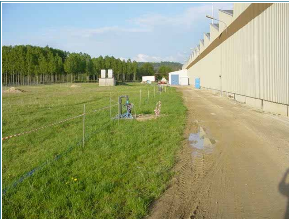
Puits de récupération
